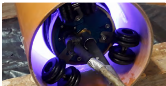
12. ábra. Folyik az UV-térhálósítás
