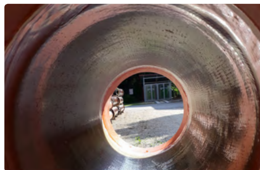
13. ábra. A 10 perc alatt kitérhálósodott csőbélelés
