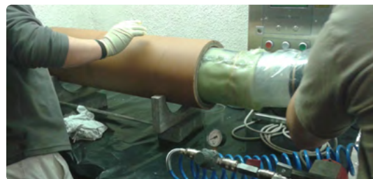
11. ábra. A prepreggel ellátott packer behelyezése a bélelendő csőbe
