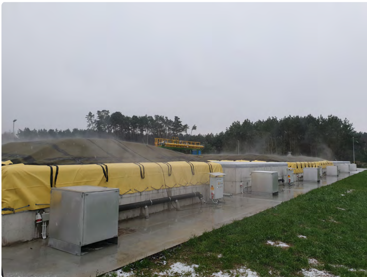
△ A ProfiKomp komposztáló rendszer specialitása a takarómembrán és a befújt levegő, amely által intenzív és gyors komposztálási folyamat érhető el teljesen szagmentesen (Forrás: ProfiKomp)
